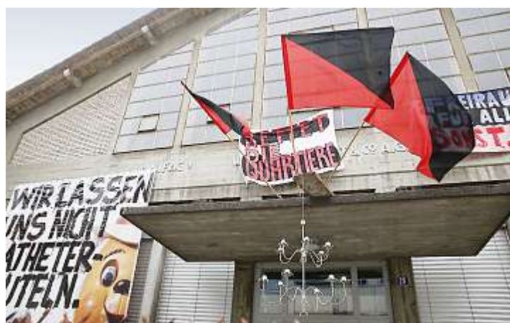
Besetzt seit Donnerstag: Die Wifag-Fabrikhalle an der Wylerringstrasse im Nordquartier. Urs Baumann
